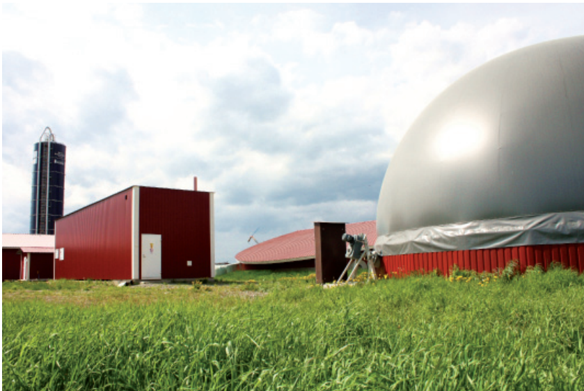
Kuva 4. Yleiskuva Haapajärven ammattiopiston biokaasulaitoksesta. © Steve Malinen
