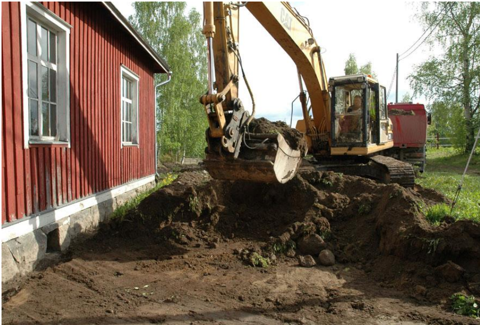
Kuva 10. Maanpinnan madallusta. Pihaa on jossain vaiheessa täytetty reilusti, hieman kauempaa talosta jopa 50 – 100 cm (JR).
