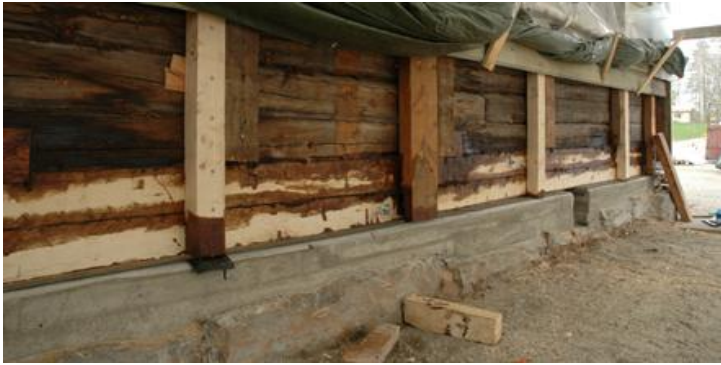
Kuva 26. Kirkon kivijalan korotus ja alimpien hirsien vaihto (JR).
