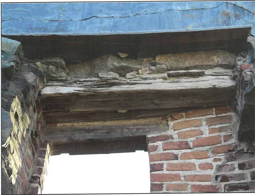
Kuva 5. Asehuoneen päätymuurin komeroaukon sisin yläpalkki, ajoitusnäyte FIH4005.
