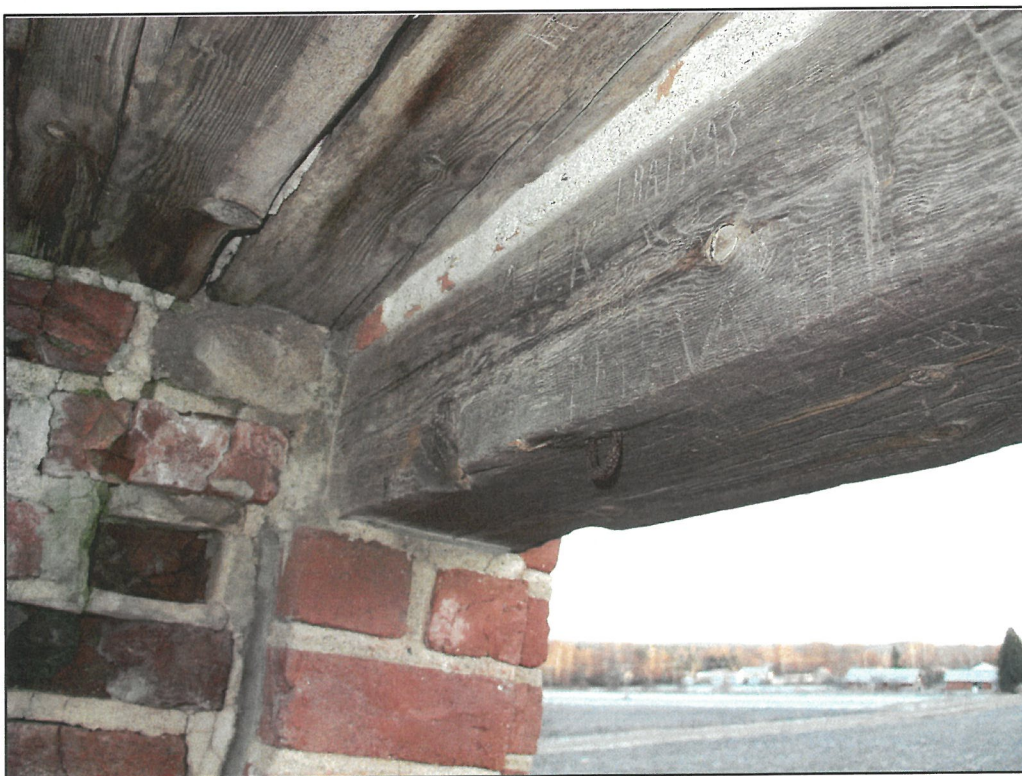
Kuva 4. Asehuoneen päätymuurin komeroaukon yläpalkki, ajoitusnäyte FIH4004.
