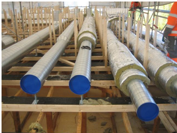
Kuva 8. Ilmanvaihtokanavien asennus vesikatolla
