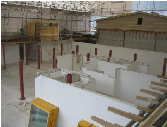
Kuva 3. Ilmanvaihtokonehuone rakenteilla
