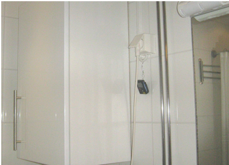
Kuva 3. Loggeri pesuhuoneen puolella. Pesuhuoneen puolella sijaitsevassa mittauspisteessä loggeri on kiinnitetty pintaan asennetun sähköjohtoon ympärille pistorasian alapuolella.
