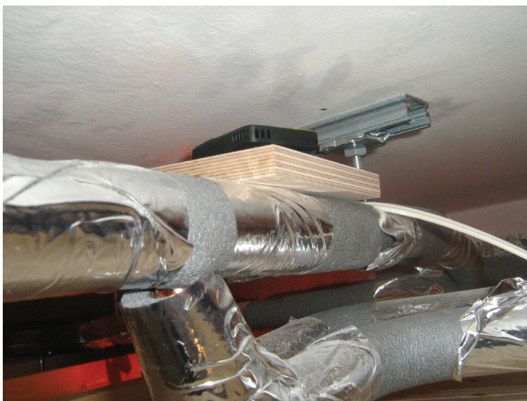
Kuva 5. Loggeri sijoitettuna lämmöneristettyjen vesijohtojen päälle. Loggerin alla on vanerilevy korokkeena ja lisälämmöneristeenä.
